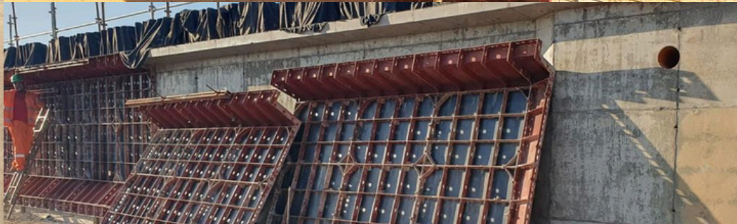
Fôrma Metálica Trepante
